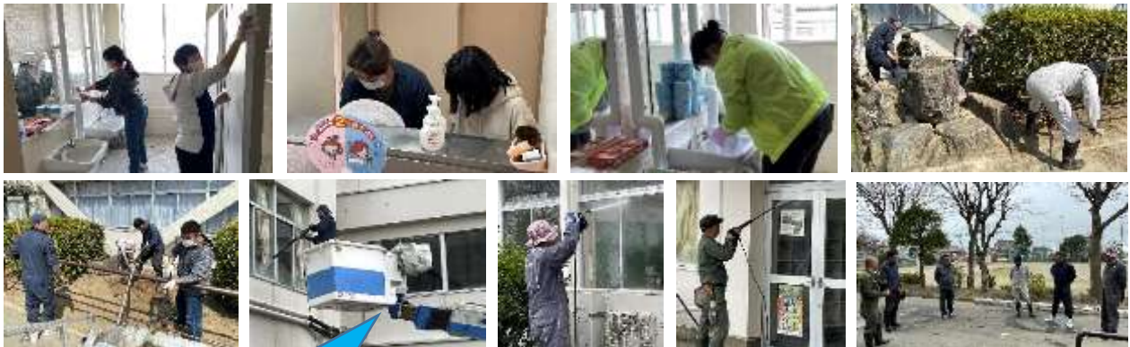
高所作業車で 2階の窓掃除!
